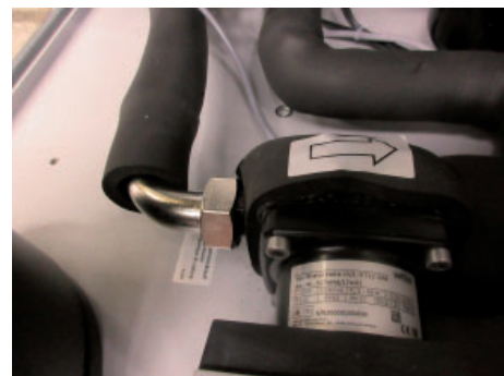
Anschluss Wärmepumpenrücklauf
