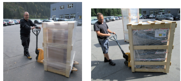
Transport der Inneneinheit und dem Außengerät mittels Hubwagen
