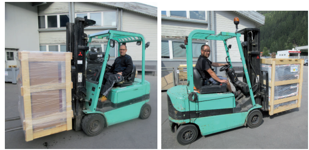
Transport der Inneneinheit und dem Außengerät mittels Stapler
