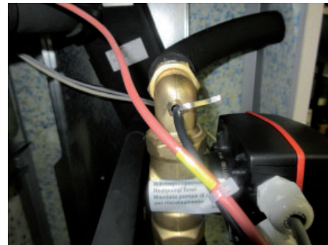
Anschluss Wärmepumpenvorlauf
