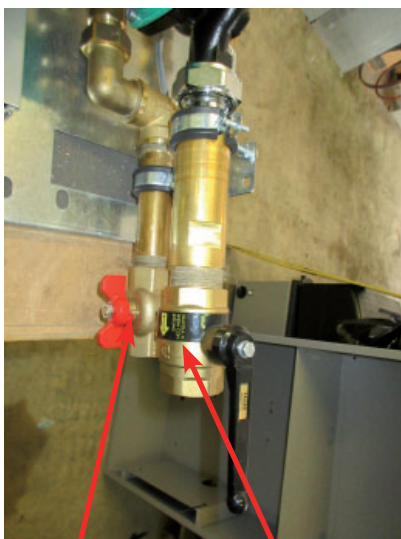
Kaltwasservorlauf Speicherrücklauf
