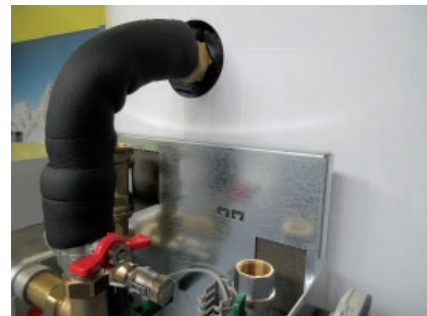
Anschluss oben mit Armaflex-Isolierung
