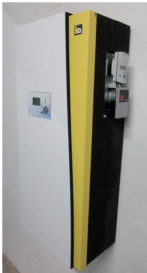
Montage der WW-Station an der Wand
