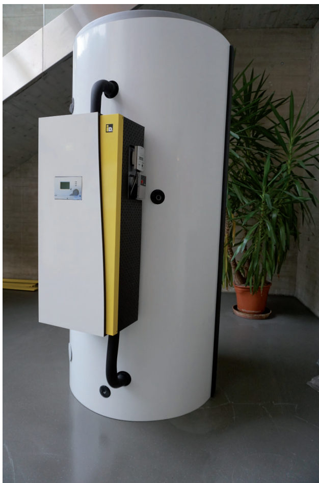
Montage der WW-Station am Hygienik
