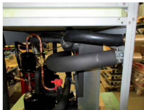
Soleanschluss von vorne gesehen auf der linken Seite mit gekürzter Soleeintrittsleitung
