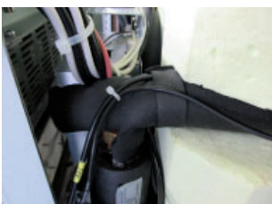
Wärmepumpenvorlauffühler B33
