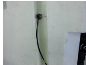
Trinkwassererwärmerfühler oben B48
