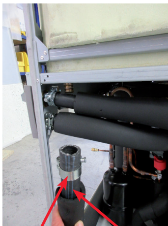
Schlauchschelle Rücklaufleitung
