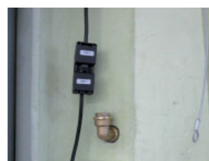
Stecker für Umschaltventil
