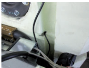
Trinkwassererwärmerfühler unten B41
