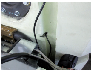
Trinkwassererwärmerfühler unten B41
