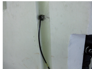
Trinkwassererwärmerfühler oben B48
