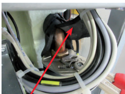
Armaflex-Isolierung
