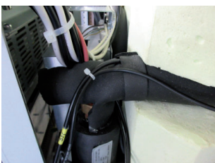
Wärmepumpenvorlauffühler B33
