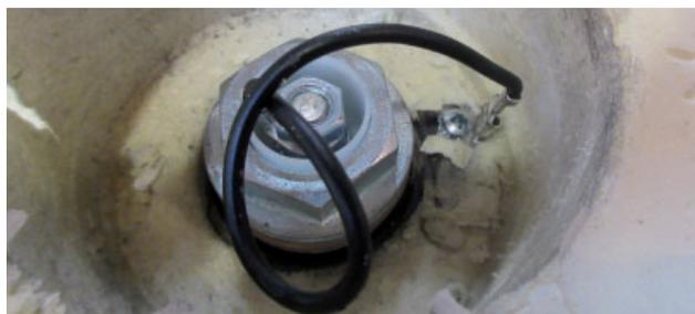
Die verbrauchte Anode wird mittels einer geeigneten Rohrzanze herausgedreht und entfernt.
