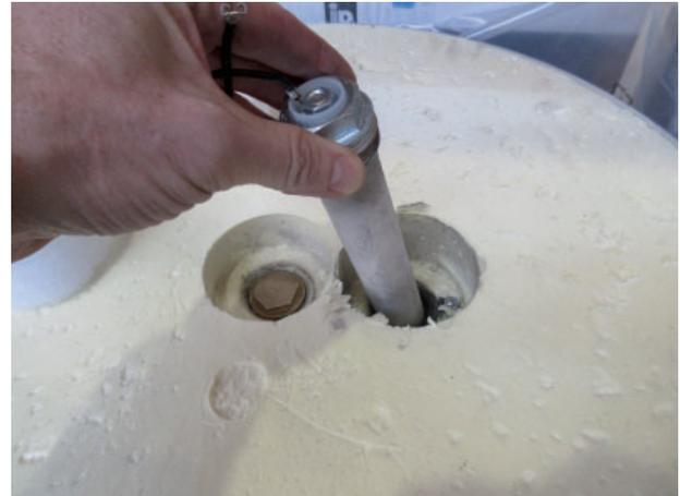
Die neue Kettenanode wird montiert und wieder fest verschraubt. Das schwarze Verbindungskabel zwischen Anode und dem Speicher muss wieder eingesteckt werden.
