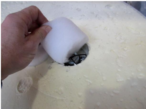
Danach wird die Verbindungsleitung zwischen Anode und dem Speicherkörper gelöst.
