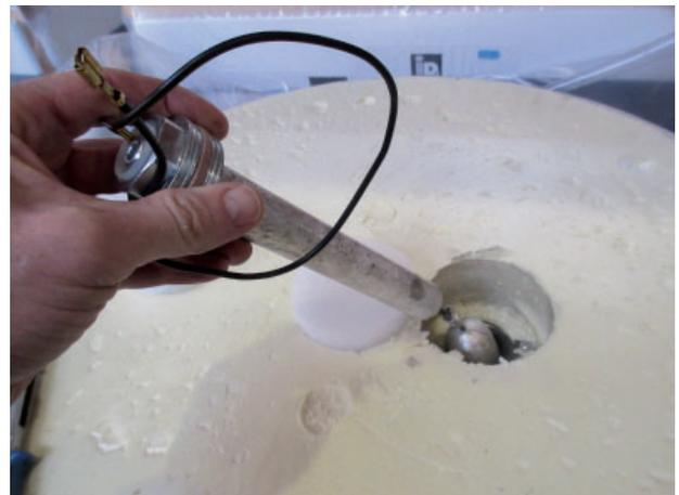
Nach der Montage der Kettenanode muss das abgelassene Wasser wieder aufgefüllt werden. Vor der Wiederinbetriebnahme der Anlage muss der Speicher im Bereich der Schutzanode auf Dichtheit geprüft werden.
