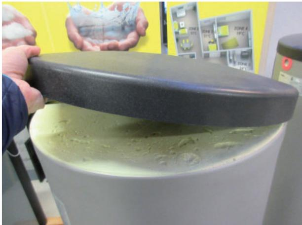
Der Schaumstoff, welcher als Isolierung im Bereich der Schutzanode dient, muss entfernt werden.
