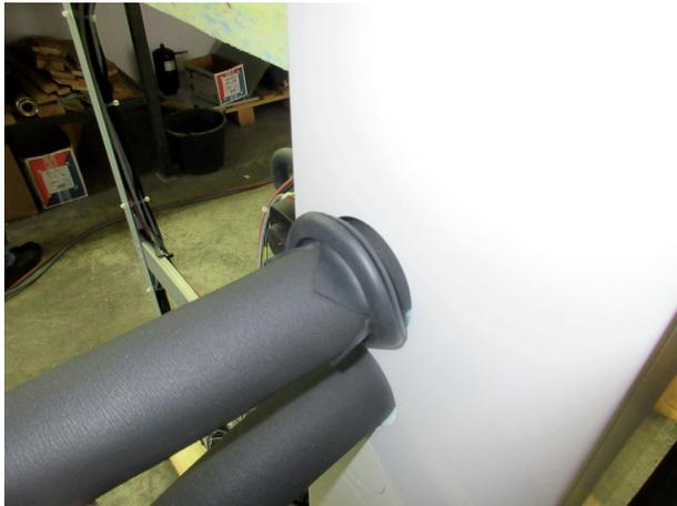
Anschlusschläuche mit fertig montierter Isolierung
