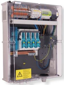
ENWITEC zentraler NA-Schutz &amp; Kuppelsch. 4xNH000 für PV-Anlagen bis 172,5kVA
