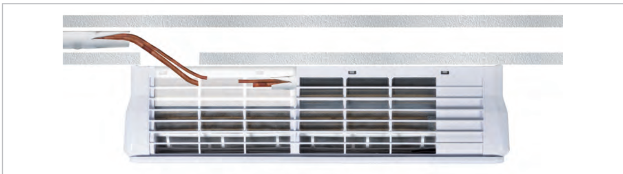
Abb. 27: Unterputzinstallation der Kältemittelleitungen (Ansicht von oben)
