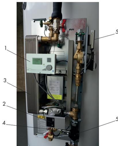
Soll die Frischwasserstation ohne Navigator-Regelung betrieben werden, besteht die Möglichkeit als Regelung eine **UVR 67** zu verwenden. Ebenfalls kann bei Bedarf optional ein **Wärmemengenzähler** montiert werden.
