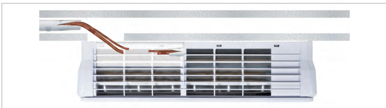
Abb. 24: Unterputzinstallation der Kältemittelleitungen (Ansicht von oben)
